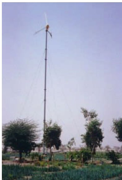
Figure 6.1 : Éolienne de pompage.
